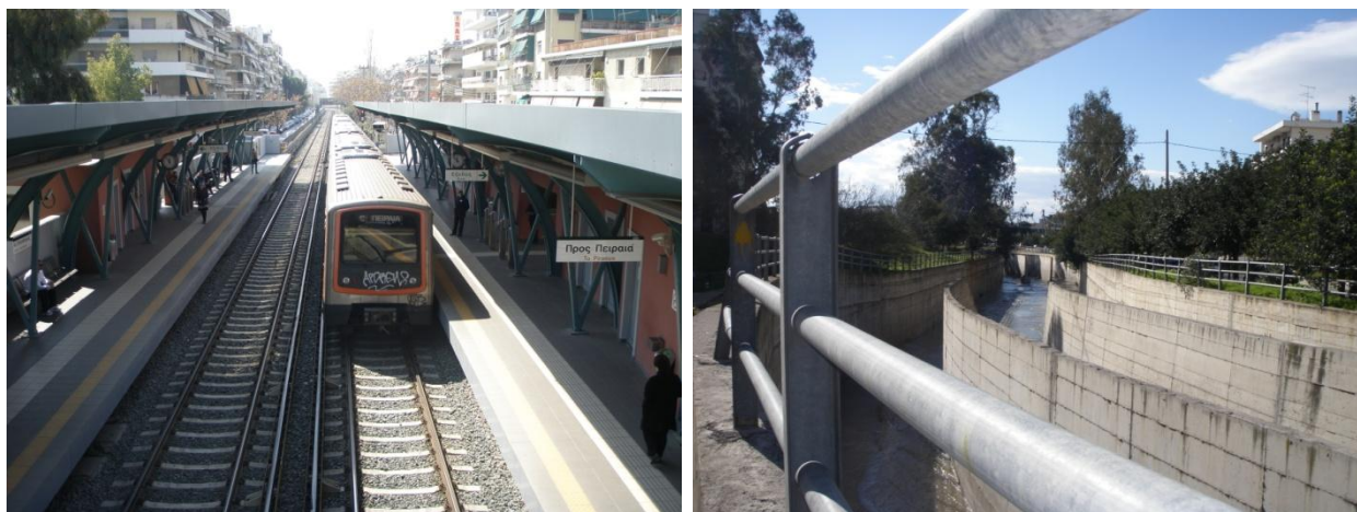
Ηλεκτρικός σταθμός Άγιος Ελευθέριος -Ποδονίφτης στην περιοχή Άγιος Ελευθέριος
